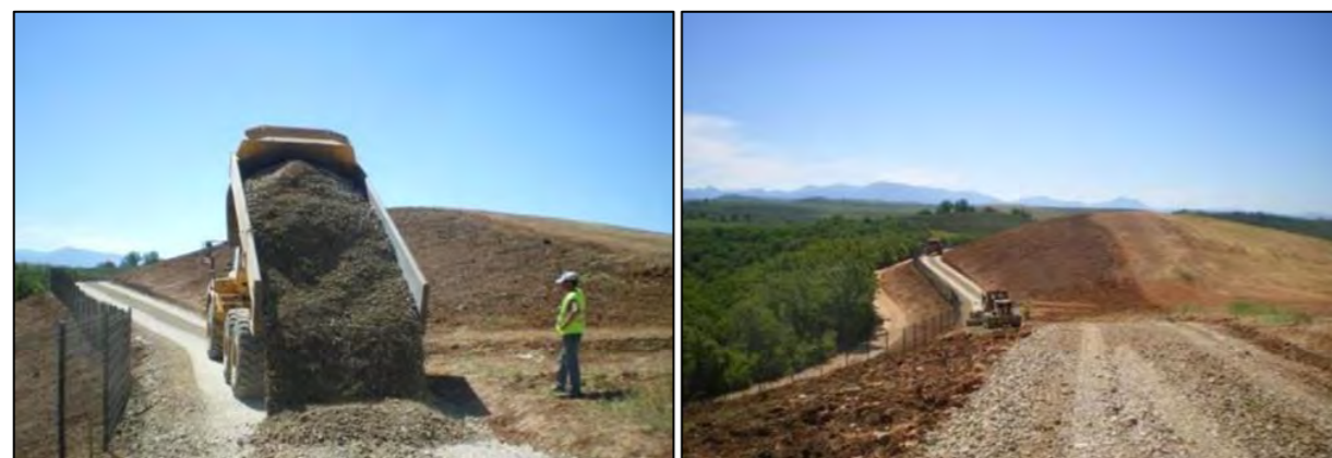
Figure 26 : Illustrations de la préparation du site (Source : MELVAN)
