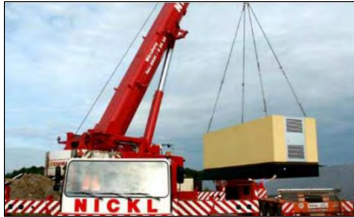
Figure 28 : Exemple d'installation d'un poste électrique (Source : MELVAN)
