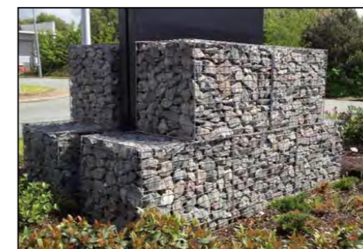
Figure 23 : Exemple de muret en gabion (Source : TCS Geotechnics)
