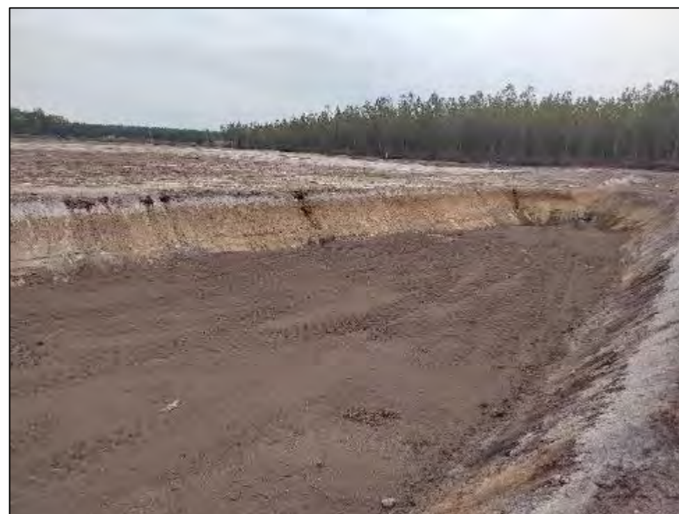
Figure 85 : Secteur en travaux (Source : ETEN Environnement)
